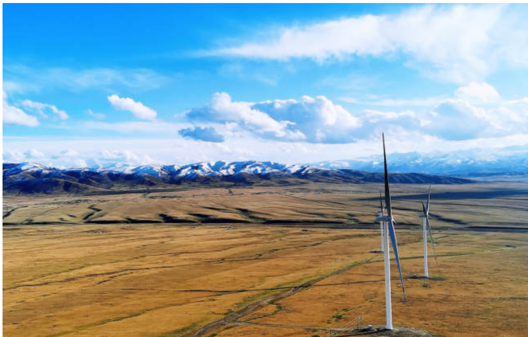
▲ 青海海西州分行提供授信支持德令哈一期光储、青豫直流二期风电和光伏项目，项目三期总装机容量分别达1000MW、500MW、100MW，有力推动当地新能源产业发展。
